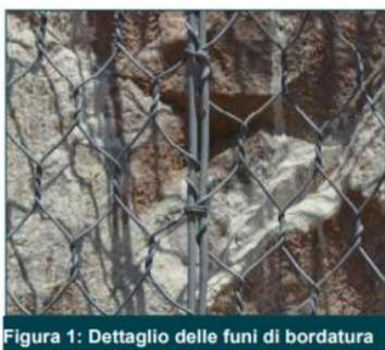
Figura 1: Dettaglio delle funi di bordatura
