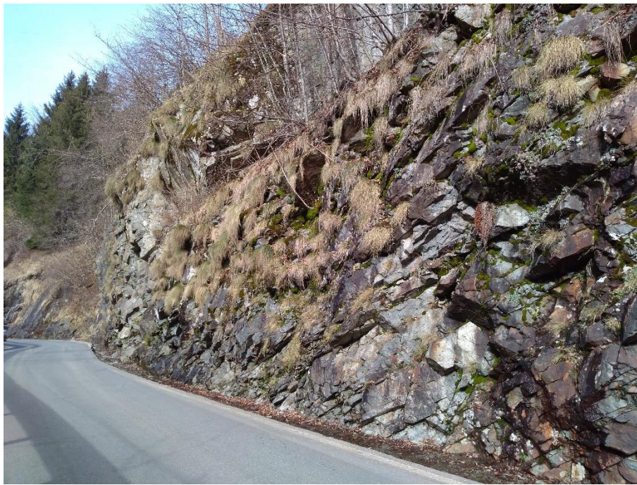
Figura 5 - Parete rocciosa oggetto di intervento
