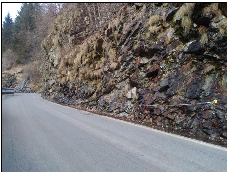
Figura 11 – Stendimento del rilievo geomeccanico
