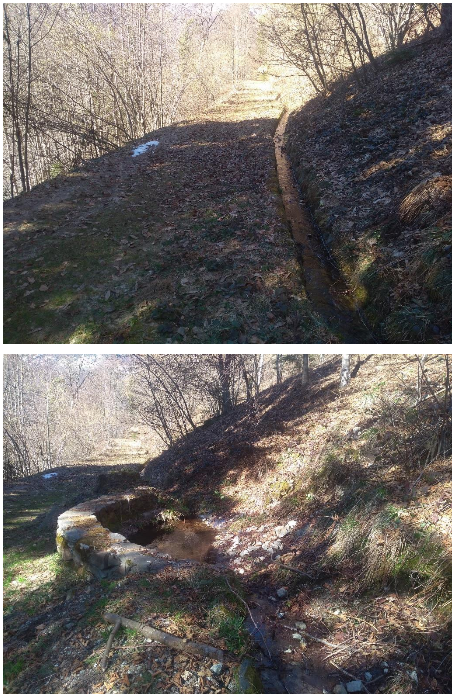
Figura 9 - Opere di regimazione presenti lungo la strada sterrata a monte della parete rocciosa oggetto di intervento
